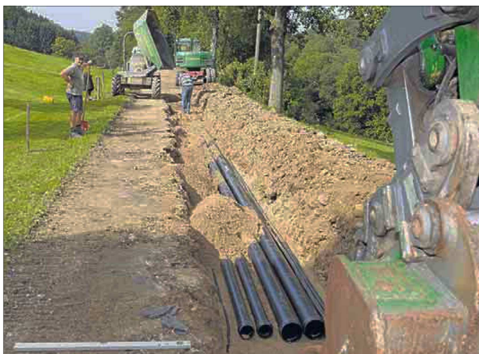
Zuerst werden wie hier in Brückerhof die Versorgungsleitungen in die spätere Radtrasse gelegt und erst dann Frostschutz und Schwarzdecke aufgetragen. (Foto: Schmitz)
